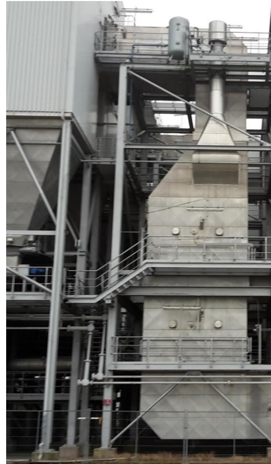
Abbildung 11 Beispielhafte Darstellung eines SCR-Reaktors (Quelle: LÜHR FILTER GmbH & Co KG)
